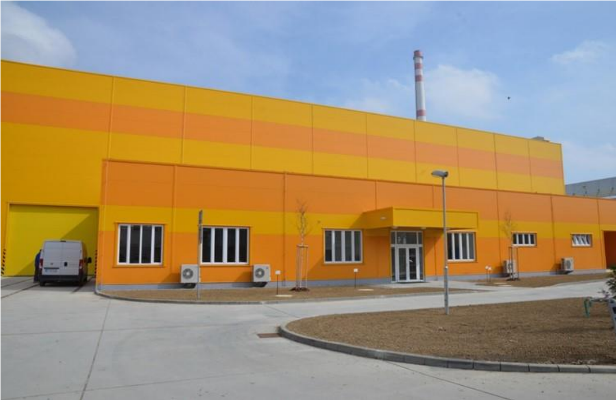
Obr. č. 17: Integrovaný sklad rádioaktívnych odpadov (IS RAO)
