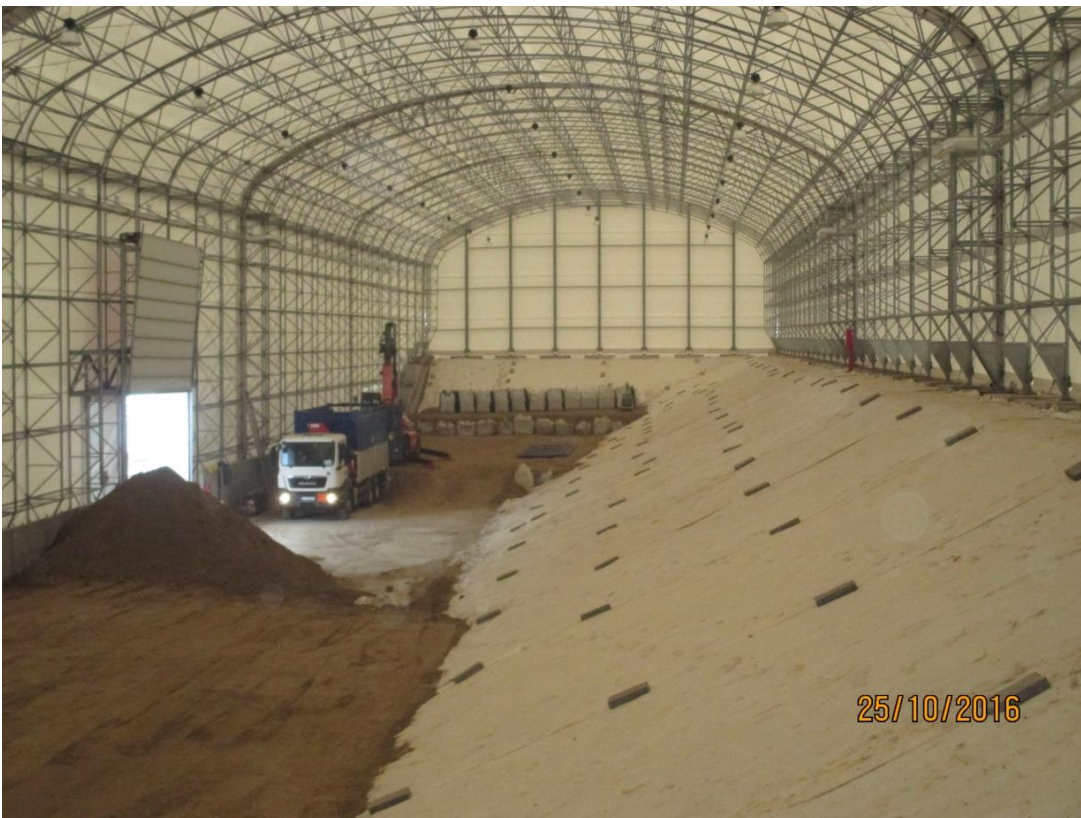
Obr. č. 22: Ukladanie VNAO v rámci 1. etapy úložiska VNAO s úložnou kapacitou 20 000 m 3 pre RAO z vyradovania JE A-1.
