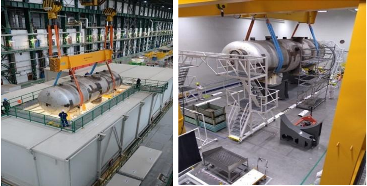
Obr. č. 24 a 25: Realizácia transportu parogenerátora PG 11 do SO 490 V-1
