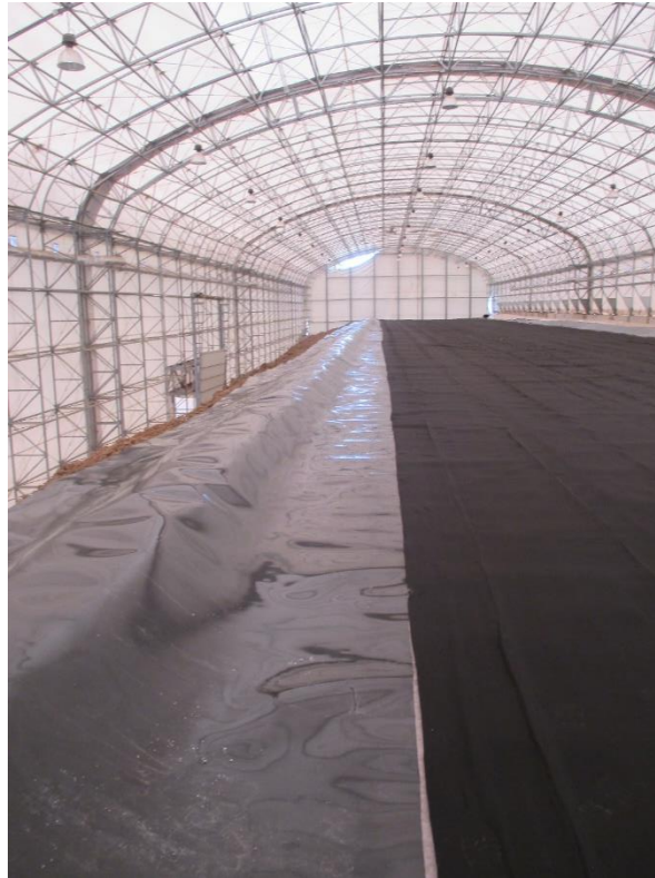
Obr. č. 23: Prekrývanie zásypovej zeminý vrstvami geotextílie
