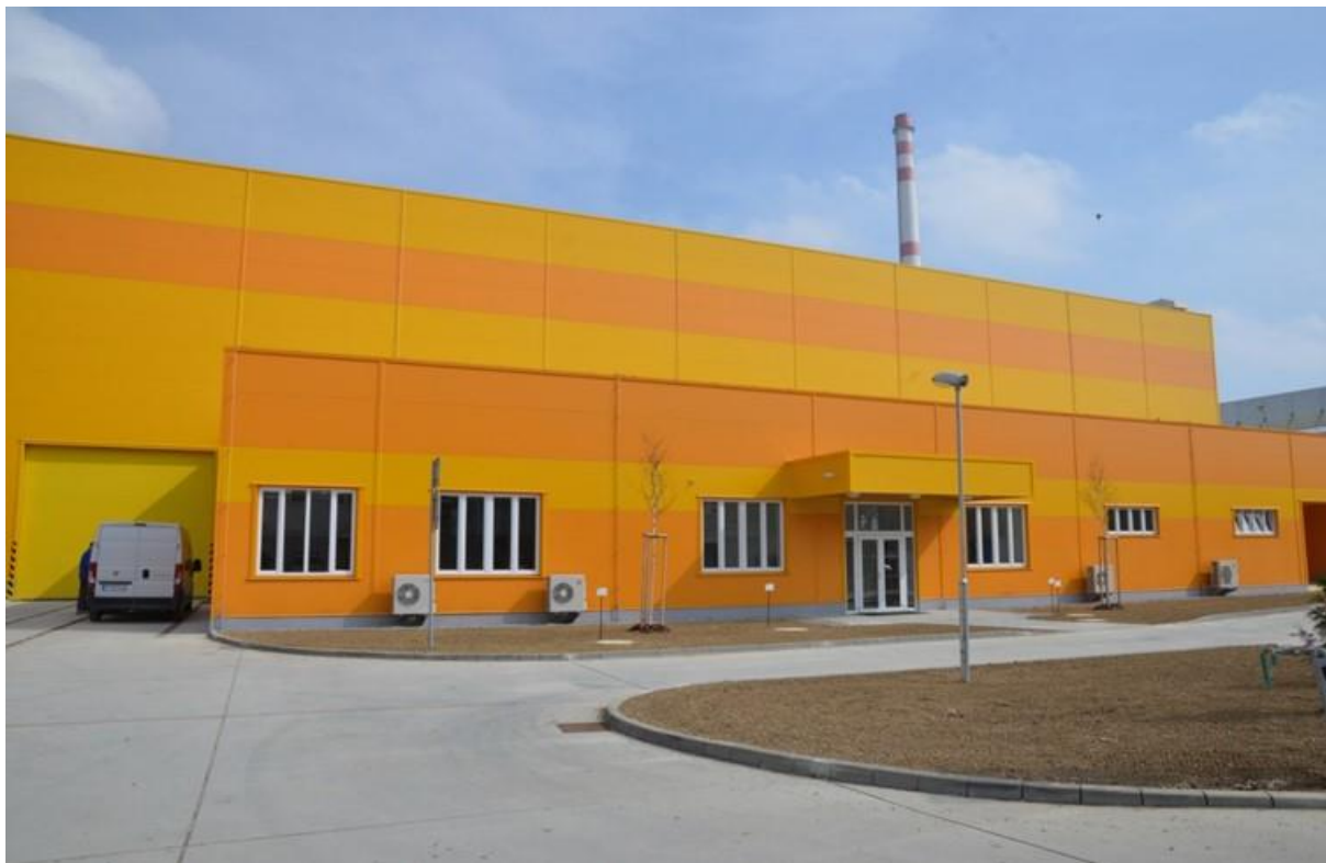
Obr. č. 5 Integrálny sklad rádioaktívnych odpadov
