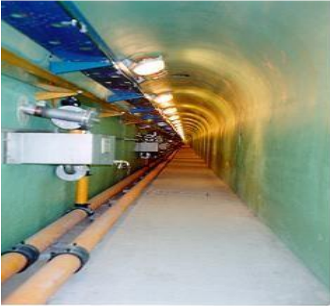
Obr. č. 26 Monitorovacie zariadenia na RÚ RAO
