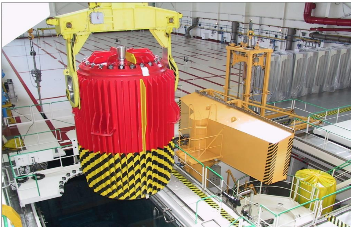
Obr. č. 3 Transport TK C-30 pomocou špeciálneho transportného závesu
