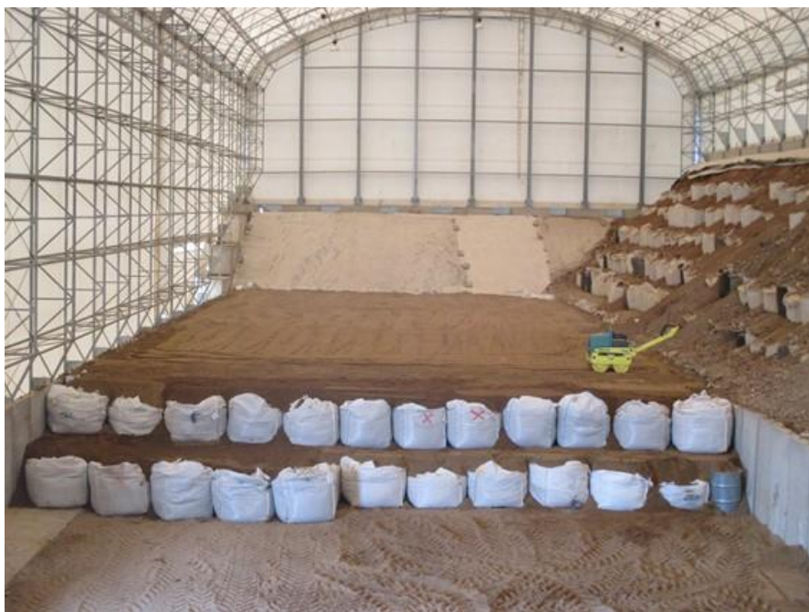
Obr. č. 10 Ukladanie VNAO v rámci 1. etapy úložiska VNAO
