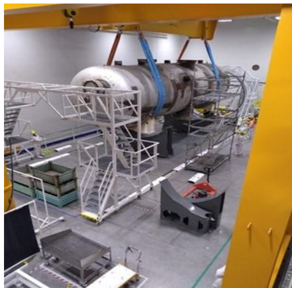
Obr. č. 12 Realizácia transportu parogenerátora PG 11 do SO 490 V1
