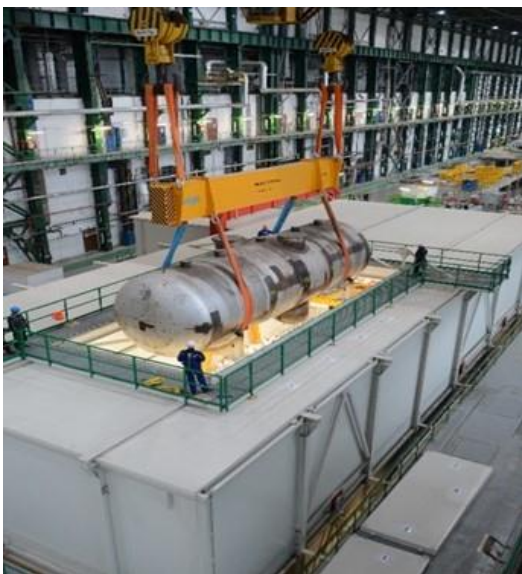
Obr. č. 12 Realizácia transportu parogenerátora PG 11 do SO 490 V1
