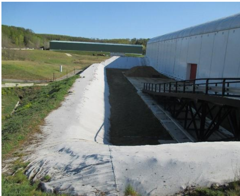
Obr. č. 11 Vybudovaná 2. etapa úložiska VNAO vedľa haly prekrytia prevádzkovej 1. etapy úložiska VNAO po jej premiestnení v roku 2019
