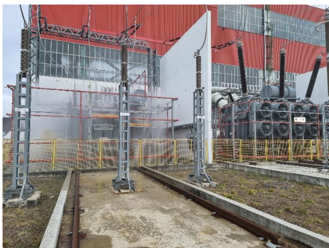
Obrázok P2-3 Skúška sprinklera vonkajších transformátorov (vľavo)
