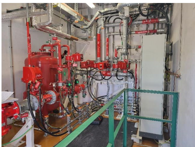
Obrázok P2-5 Pohľad do strojovne SHZ na penu v DG stanici (vľavo)
