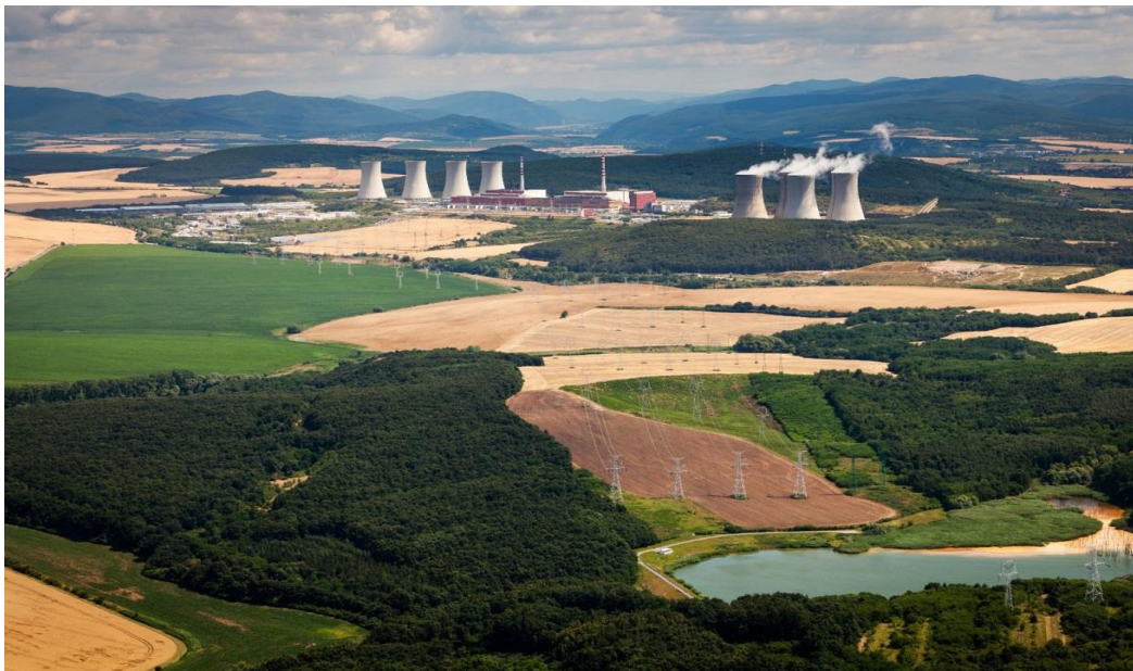
Obr. č. 6 Jadrová elektrárň lokalita Mochovce
