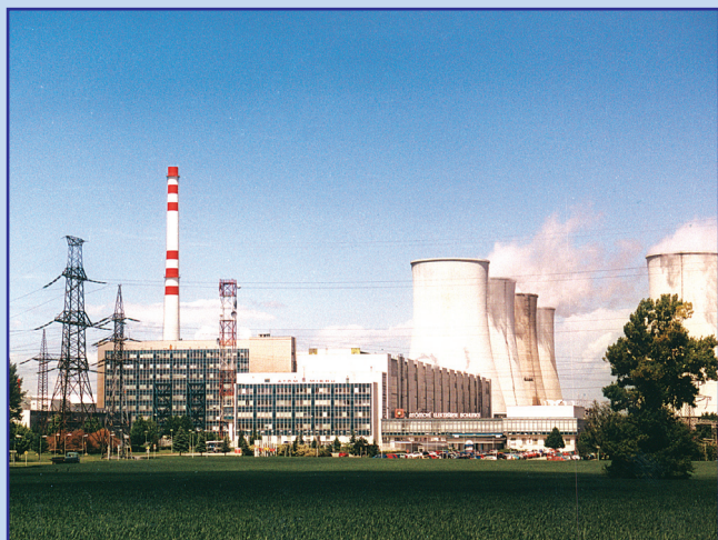
Pohľad na JE V-1 View of NPP V-1
