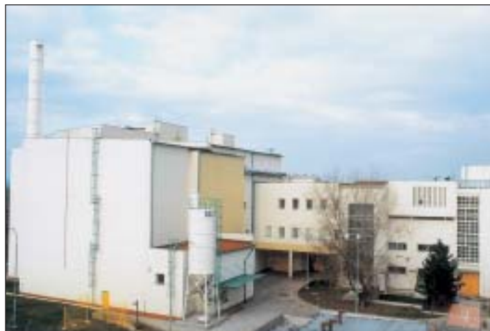
Pohľad na budovu Bohunického spracovateľského centra RAO
