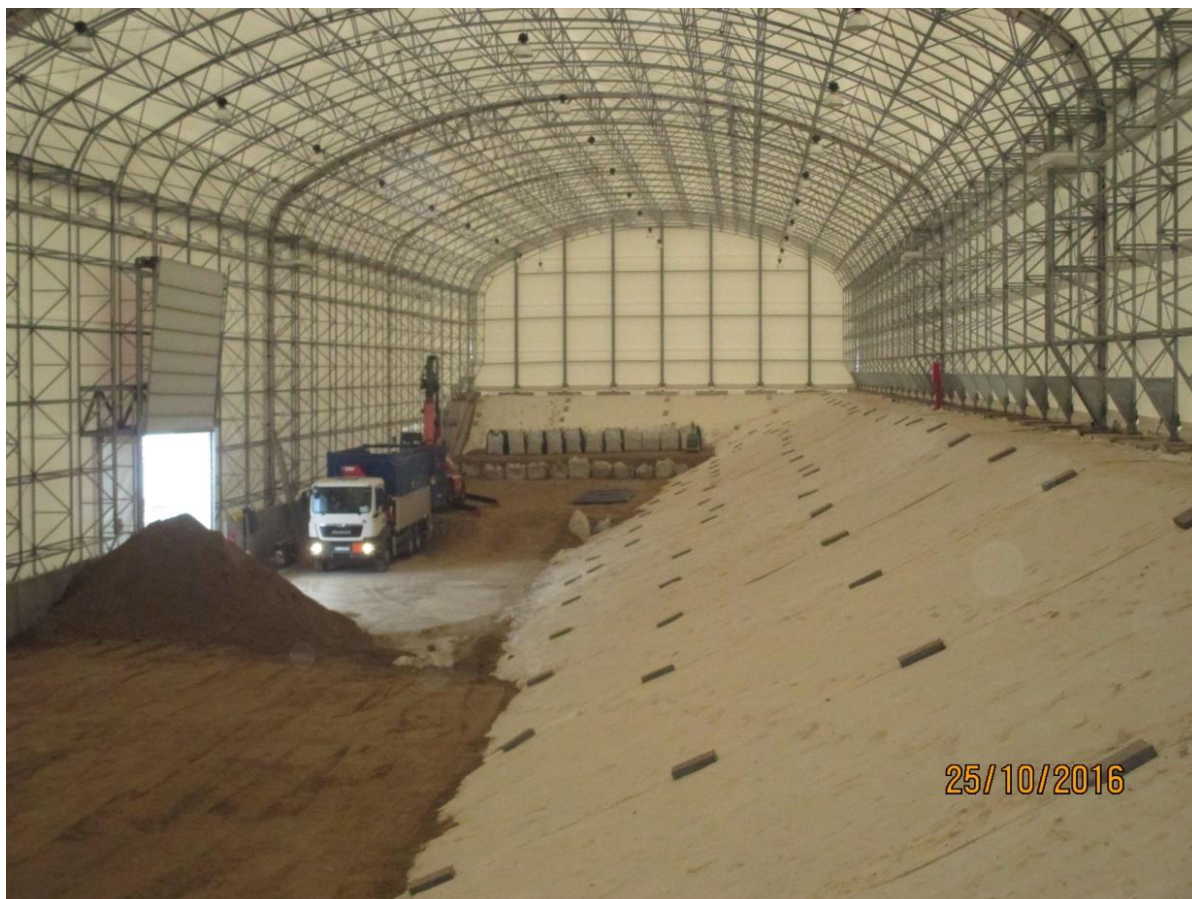
Obr. č. 20: Ukladanie VNAO v rámci 1. etapy úložiska VNAO s úložnou kapacitou 20 000 m 3 pre RAO z vyradovania JE A-1.
