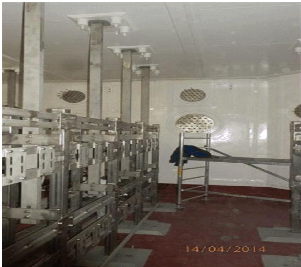
Obr. Seizmické z odolnenie meracej miestnosti v HVB (EMO 3 a 4)
