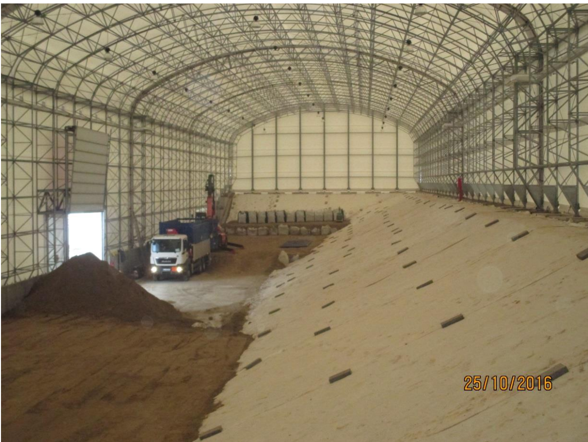
Obr. Ukladanie VNAO v rámci 1. etapy úložiska VNAO s úložnou kapacitou 20 000 m 3 pre RAO z vyradovania JE A 1.
