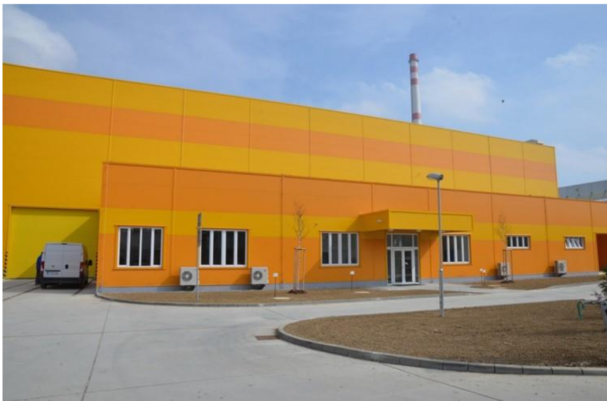
Obr. č. 5 Integrovaný sklad rádioaktívnych odpadov
