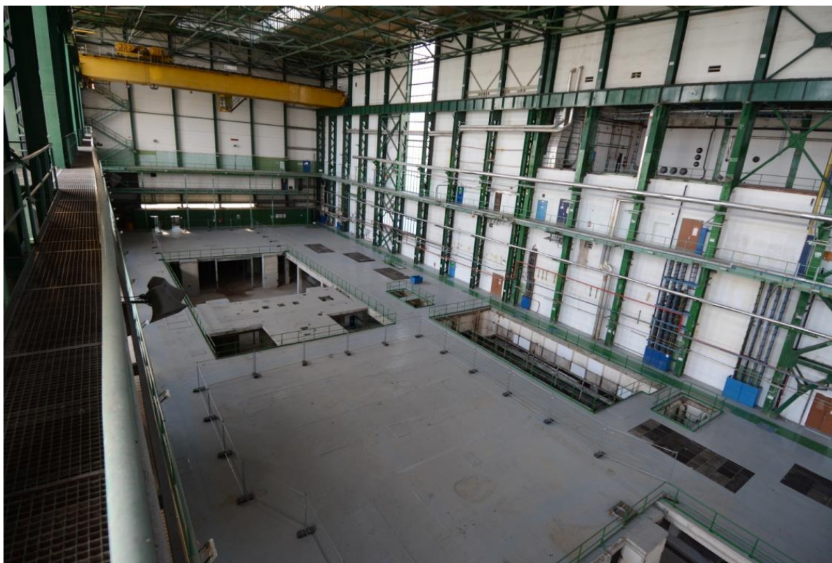
Obr. D.3.1 Objekt strojovne po demontáži technologickej časti
