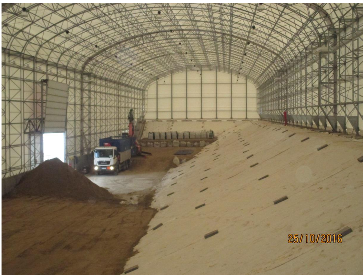
Obr. D.2.7b) Ukladanie VNAO v rámci 1. etapy úložiska VNAO s úložnou kapacitou 20 000 m 3 pre RAO z vyradovania JE A 1.
