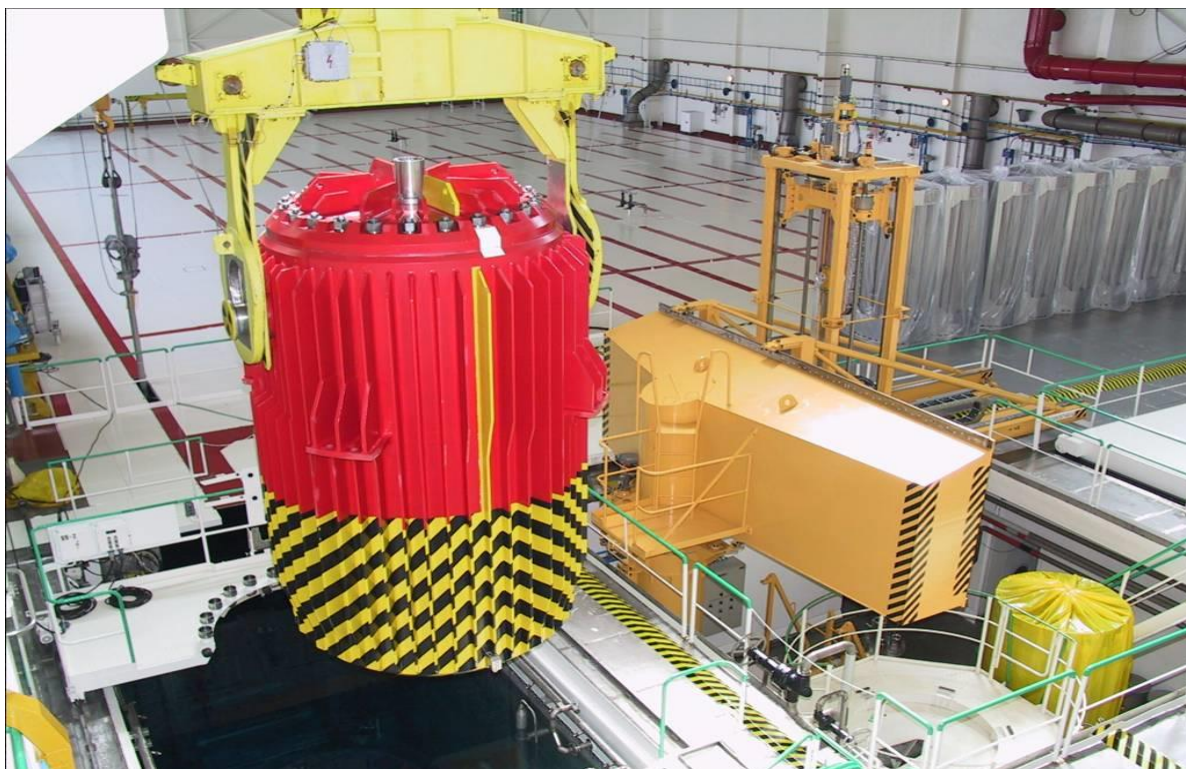
Obr. D.1.2d) Transport TK C-30 pomocou špeciálneho transportného závesu
