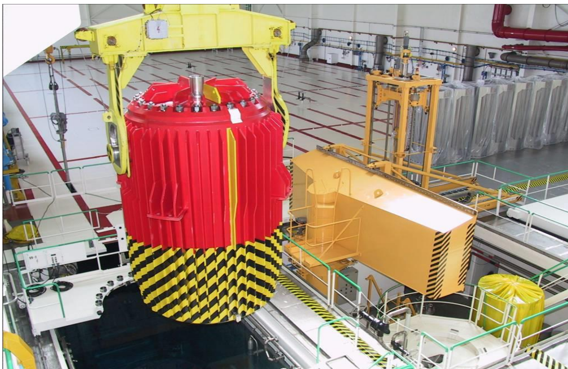
Obr. D.1.2b) Transport TK C-30 pomocou špeciálneho transportného závesu
