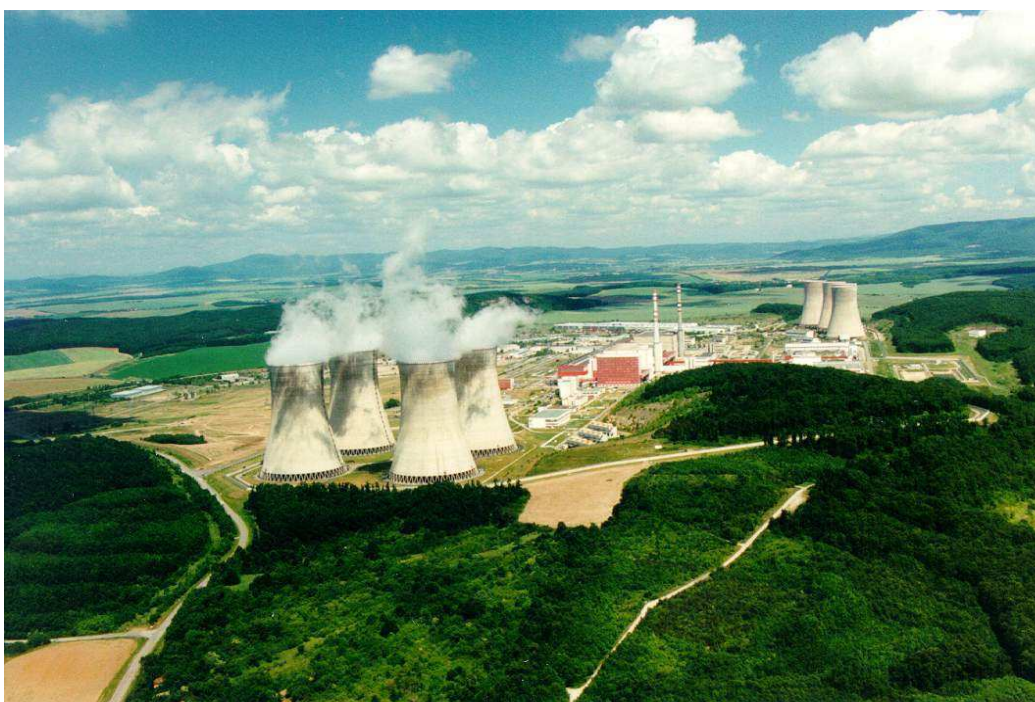
Obr. 3: Celkový pohľad na lokalitu Mochovce
