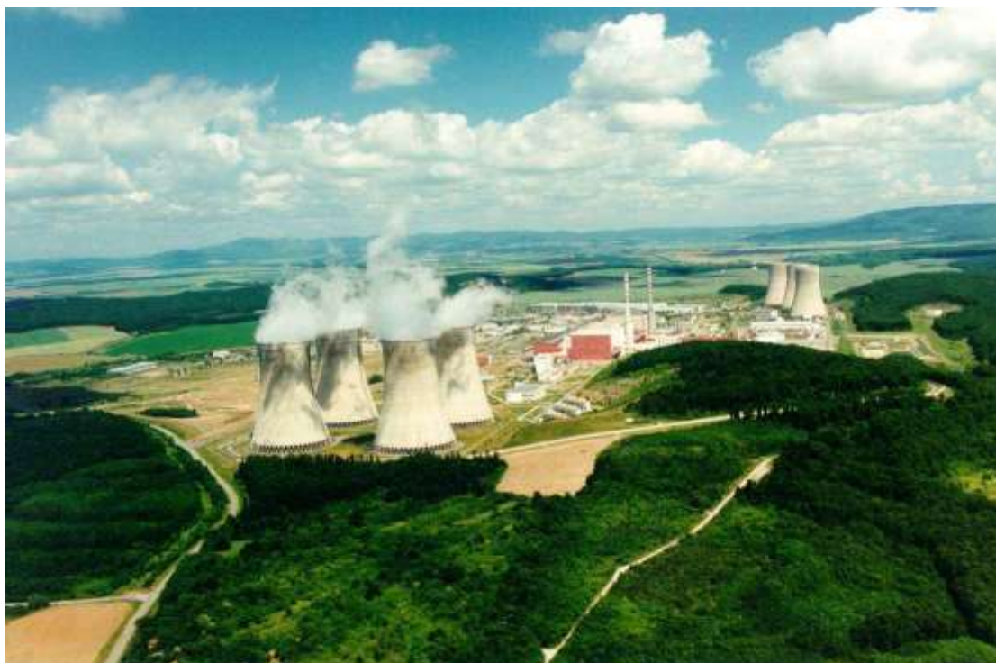
OBR. 3: Celkový pohľad na lokalitu Mochovce
